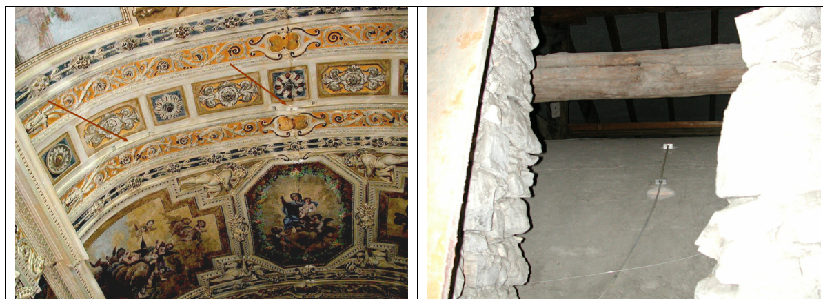
Rys. 17. Czujniki SOFO na sklepieniu nawy kościoła w Gandrii (zdjęcie autora)
